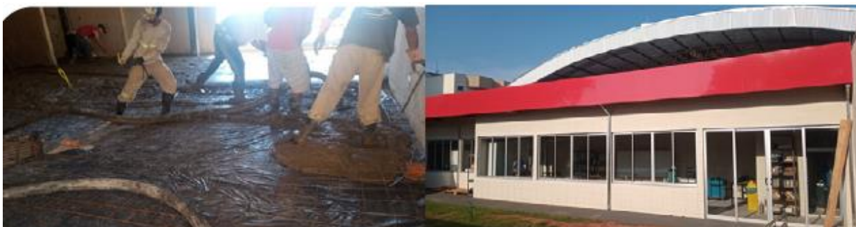
Figura 57 - Construção dos Laboratórios de Engenharia Mecânica e Civil
