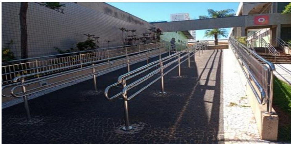
Figura 36 - Continuação da adequação do projeto de acessibilidade arquitetônica referente instalações de guarda-corpos e corrimãos
