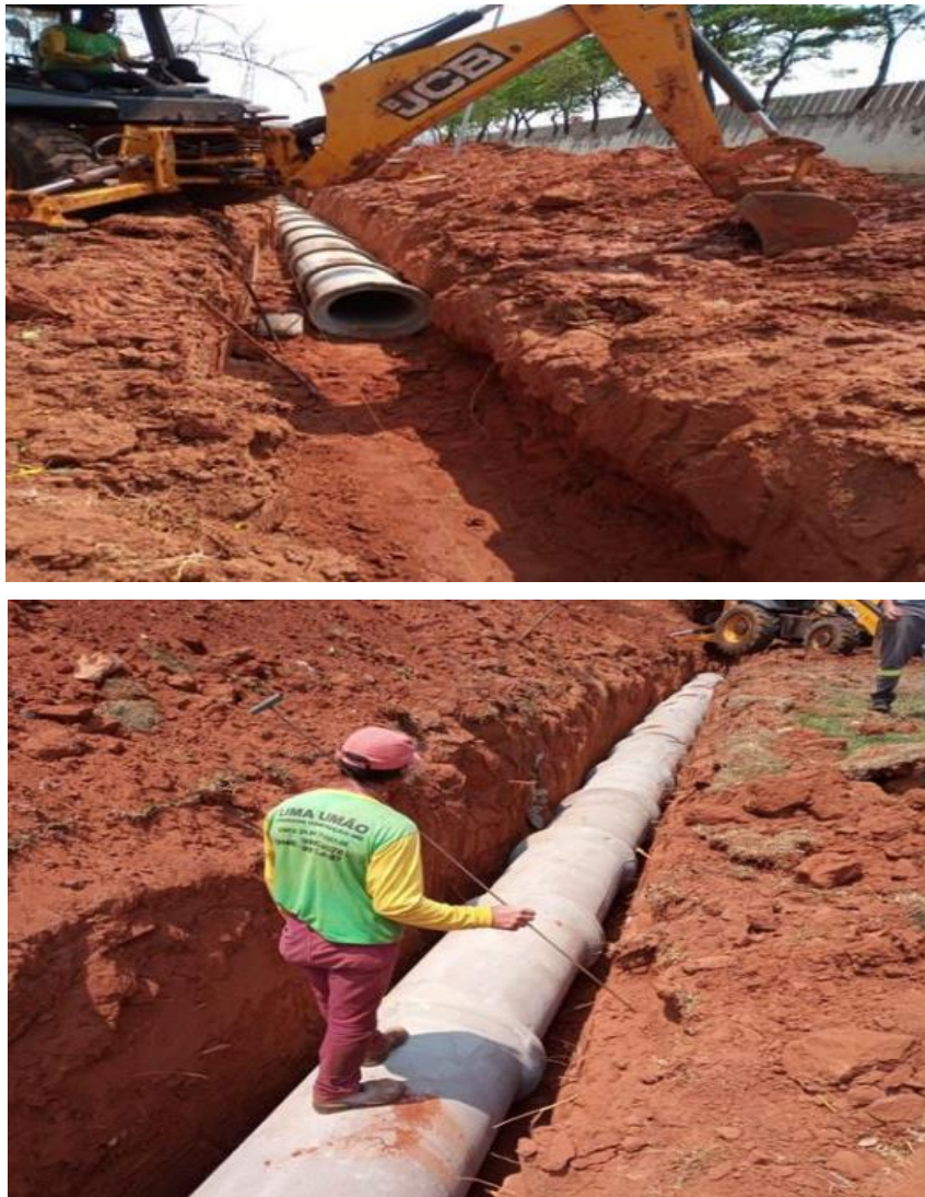
Figura 42 - - Instalação de rede de água pluvial entre os Blocos J e G
