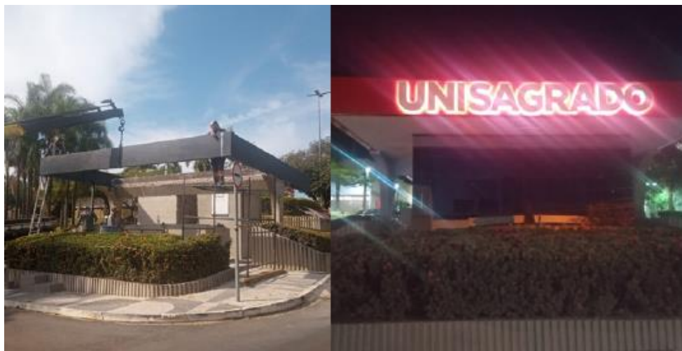
Figura 55 - Reforma Guarita – Antes x Depois
