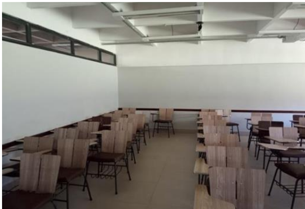
Figura 47 - Reforma, pequenos reparos e pintura nas salas de aula dos Blocos F-G-J-K
