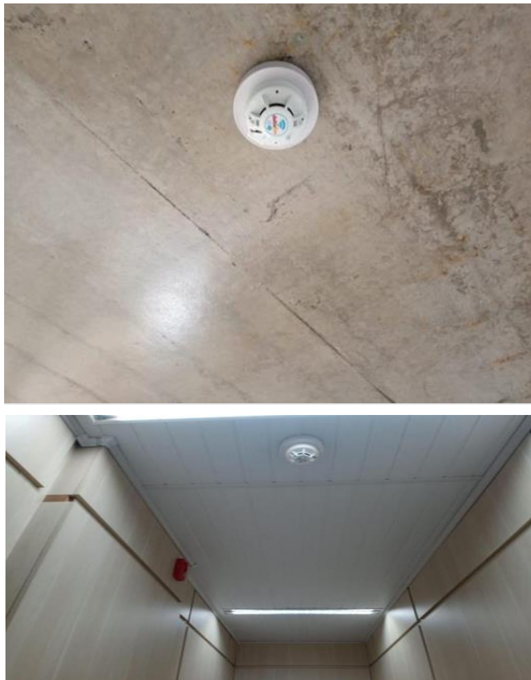
Figura 53 - Instalação de sensores de fumaça no Bloco O e gerador
