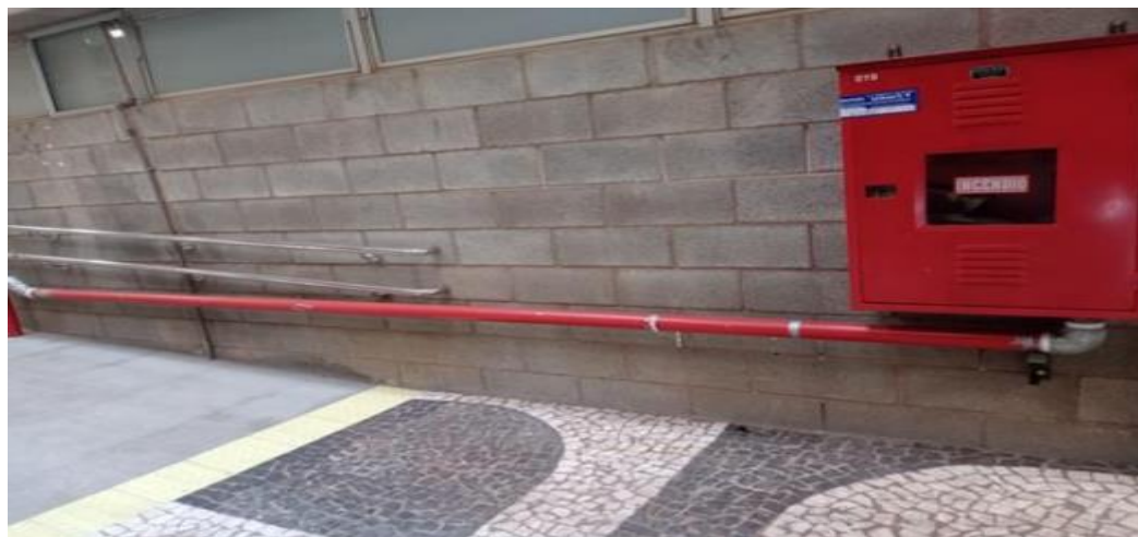
Figura 50 - Readequação de hidrantes
