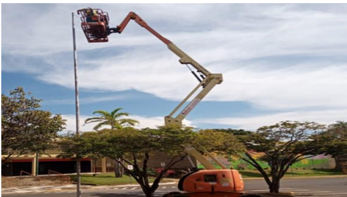
Figura 62 - Instalações de Postes de Iluminação no Bloco L e ruas do câmpus
