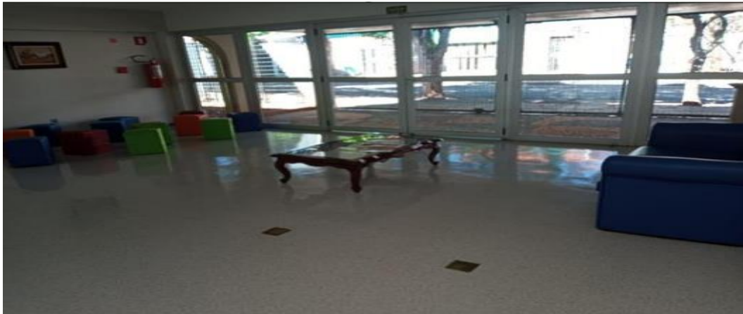
Figura 38 - Reforma e adequação do Laboratório de Enfermagem e Nutrição (Depois)
