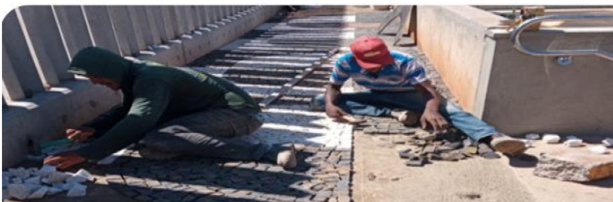
Figura 58 - Calçada Interna ao lado da Rodovia Marechal Rondon
