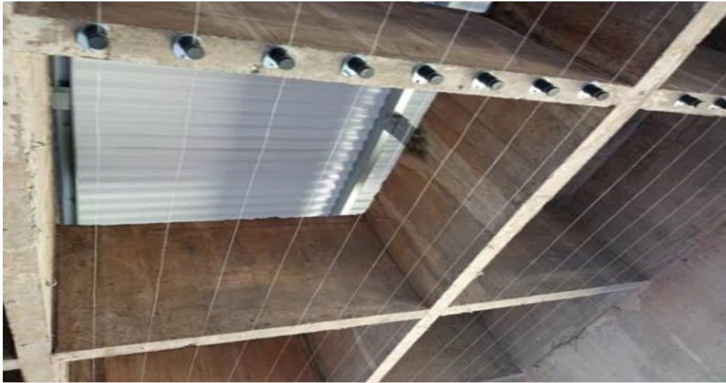
Figura 46 - Instalação de sistema anti pombos entre os Blocos A e F
