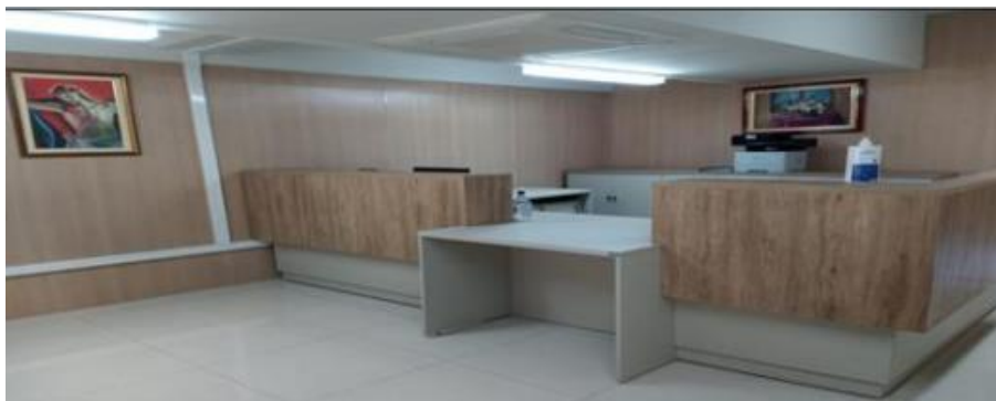
Figura 44 - Finalização da Reforma do Setor de Graduação e Pós-graduação e adequação dos aparelhos de ares condicionados no Bloco G
