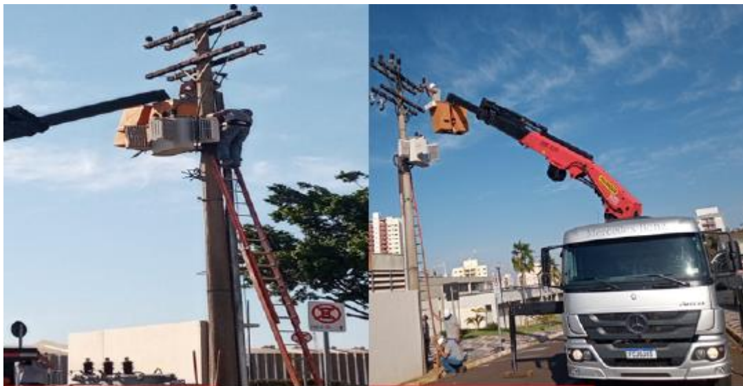
Figura 54 - Troca do Transformador bloco L
