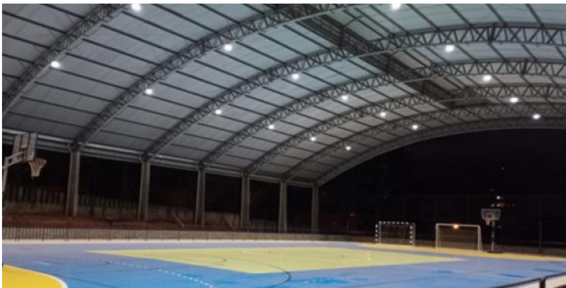
Figura 63 - Troca de iluminação da Quadra Poliesportiva
