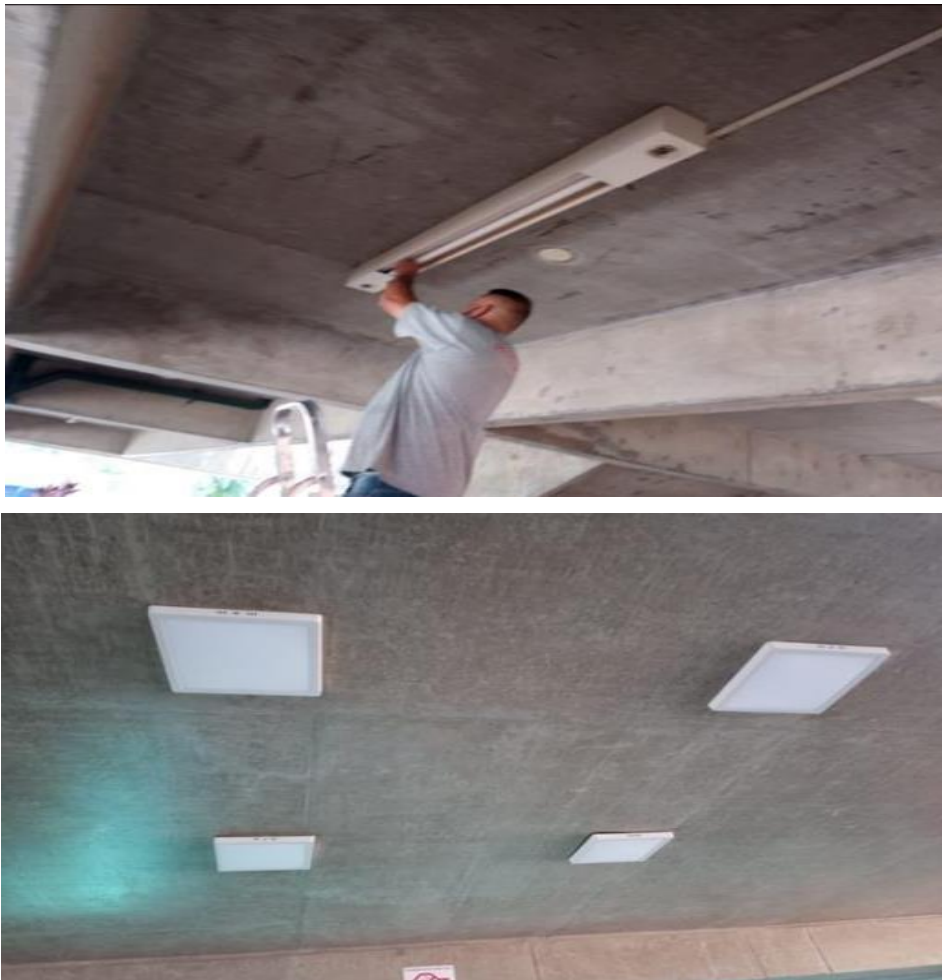
Figura 52 - Substituição de lâmpadas fluorescentes por Led no Bloco O
