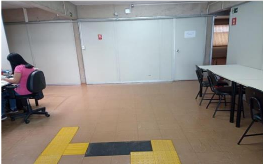
Figura 39 - Reforma e adequação do Arquivo Central
