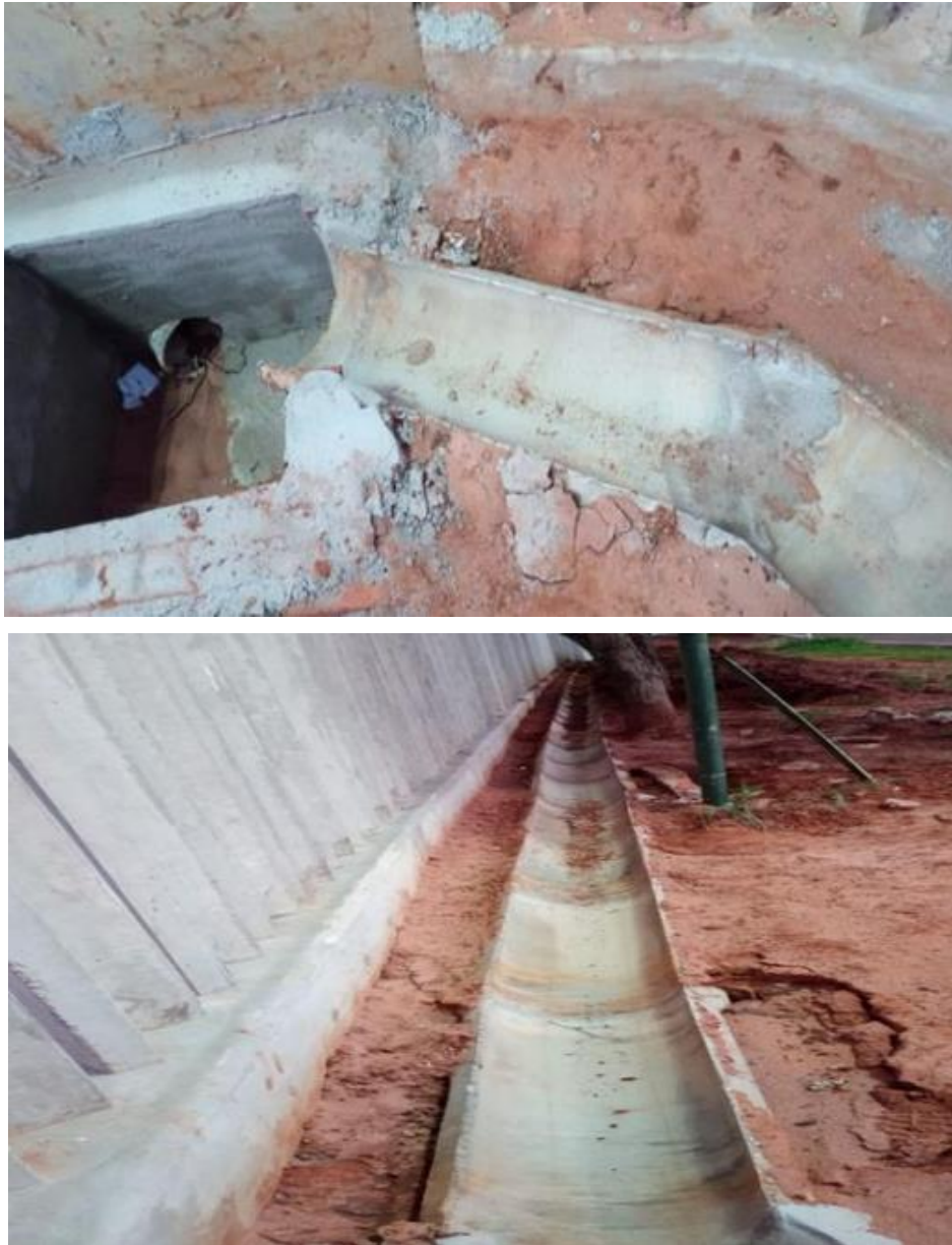
Figura 45 - Construção de canaleta para captação de água, talude e plantio de grama na lateral do muro paralelo a Via Rondon, entre os Blocos A e F
