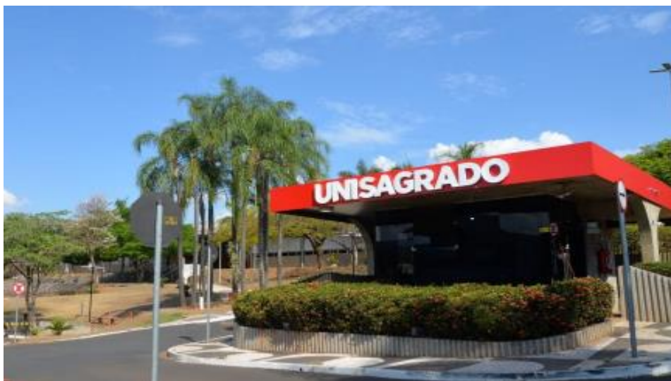
Figura 56 - Reforma Guarita – Depois
