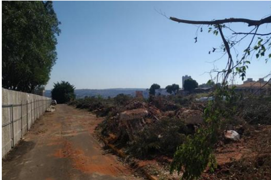
Figura 43 - Construção do muro lateral, paralelo a Via Rondon
