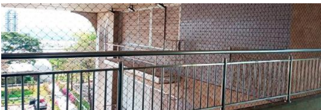
Figura 66 - Instalação de rede de proteção no 2º e 3º andar do Bloco J
