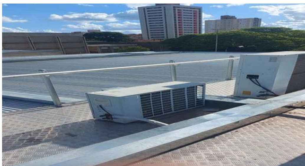
Figura 49 - Instalação de guarda corpo nos corredores e poços dos Blocos J-K
