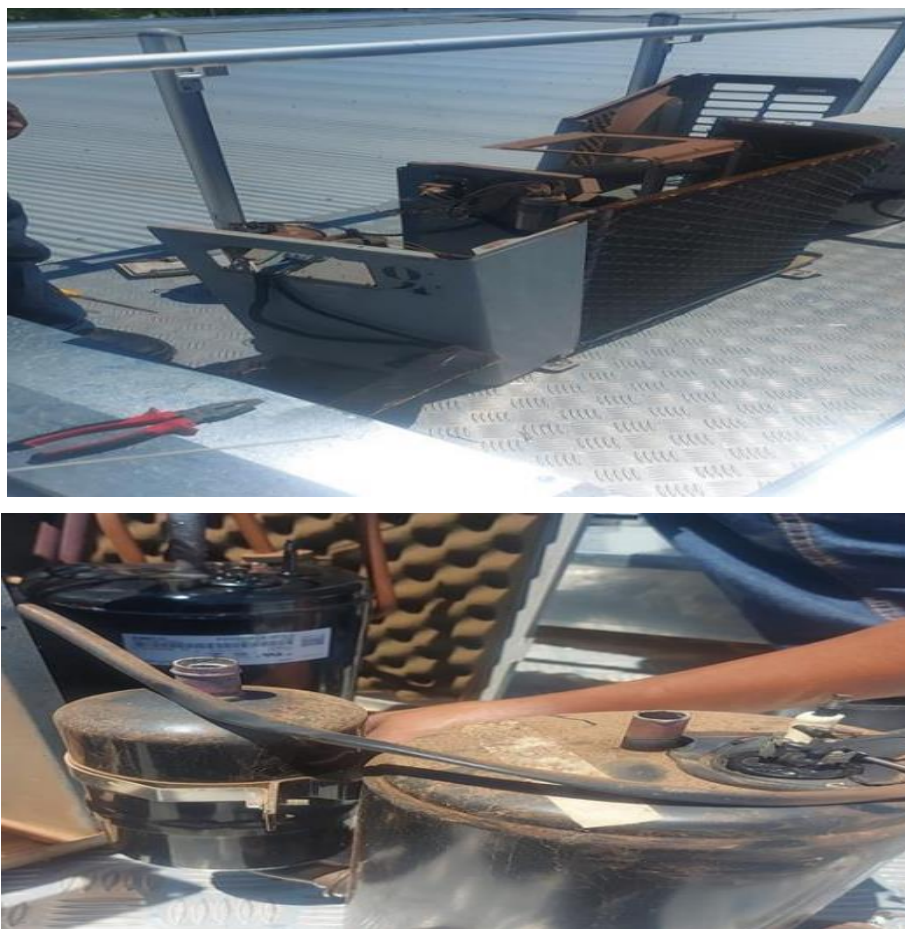
Figura 48 - Manutenção preventiva e corretiva em ares condicionados
